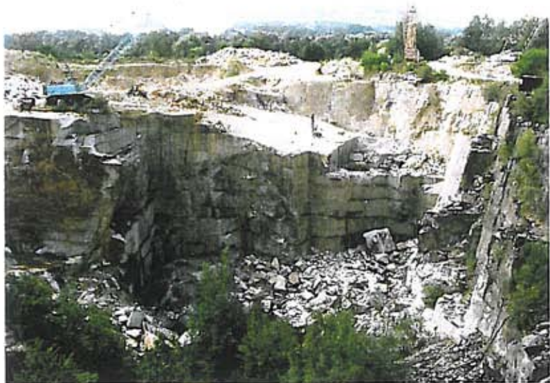
Bruch „Kühne“ – Abbau an der West- und Südböschung
