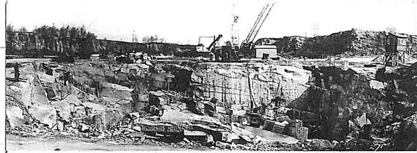
Abb. 3 Rohblockgewinnungsstelle tiefer +280 m NN von SW, März 1989.
